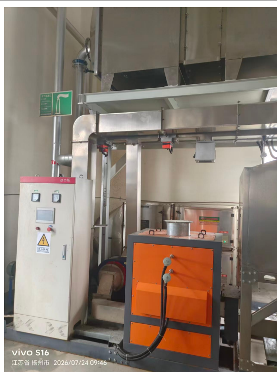
DA001排气筒和标识牌
